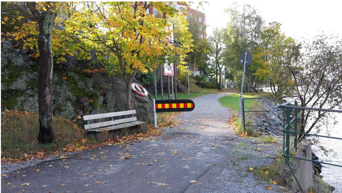
Figur 7. Arbetsområdet på land sett mot väster. Strandpromenaden går över de befintliga ledningarna. Bostadshuset på Östra Finnbodavägen 15 syns bakom träden. Foto: Ylva Nilsson
