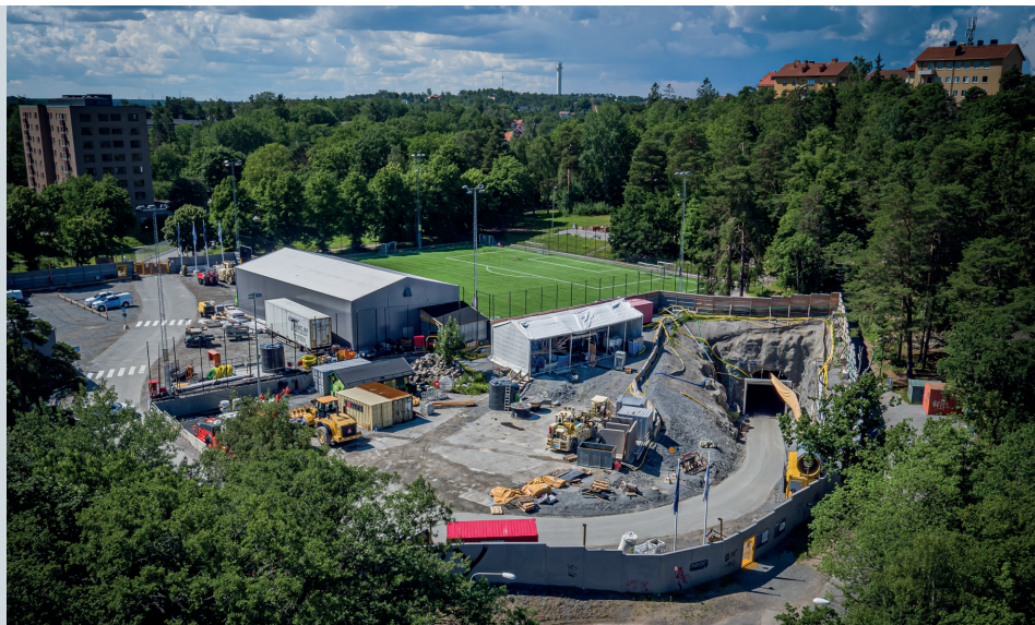
Ena halvan av Axelsbergs bollplan används som byggetablering för avloppstunneln i Eolshäll. En 400 meter lång arbetstunnel har byggts ner till avloppstunneln, ca 35 meter under Mälarens nivå.
