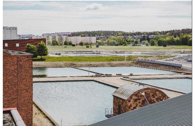
Bild från Norsborgs vattenverk
