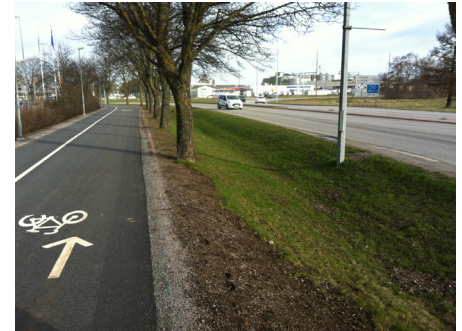
Svackdike mellan väg och cykelväg.
