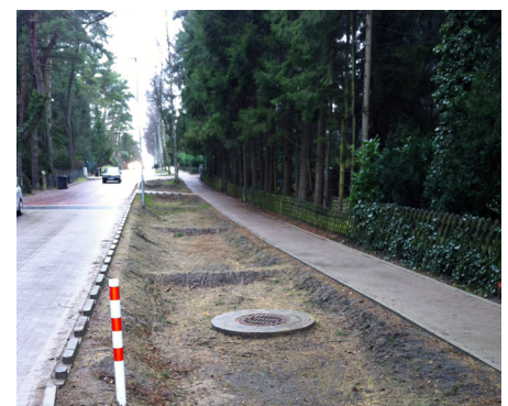
Svackdike med dämmen och bräddavlopp.
