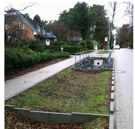
Svackdike med inloppsledning och dämmen.
