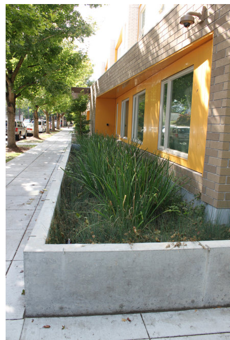
Denna växtbädd tar hand om takdagvatten som leds dit via husets stuprör.
