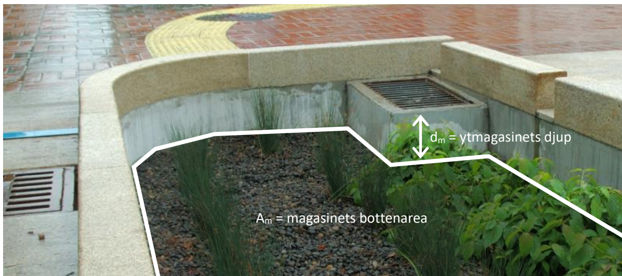
Figur 6 Illustration av de geometriska magasinparametrarna i ekvation 2 och ekvation 3.
