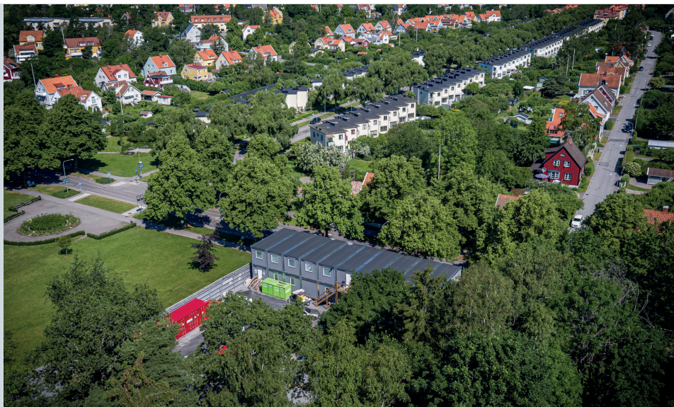
Byggetableringen i Smedslätten ligger vid Alviksvägen intill Ålstensängen. Från tunnelmynningen har flera arbets- och servicetunnlar sprängts fram söderut mot Mälaren.
