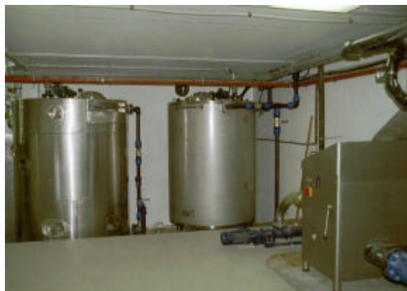
Figur 2. Hygieniseringssteg till vänster och blandningstank för normalt matavfall och klosettatten till höger (Foto: Martin Oldenburg, OtterWasser)
