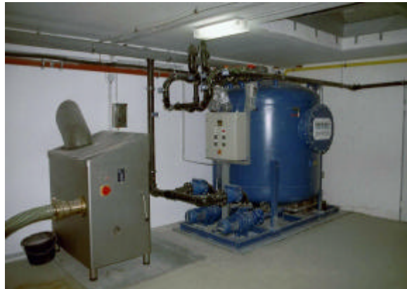
Figur 1. Till vänster: Station för tillförsel av matavfall med kvarn. Till höger: vakuumpumpstation (Foto: Martin Oldenburg, OtterWasser)
