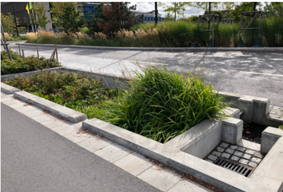
Höger: Rain garden Neptunigatan, Malmö. Vänster: Vatten leds in i rain garden via en öppning i kantsten.
